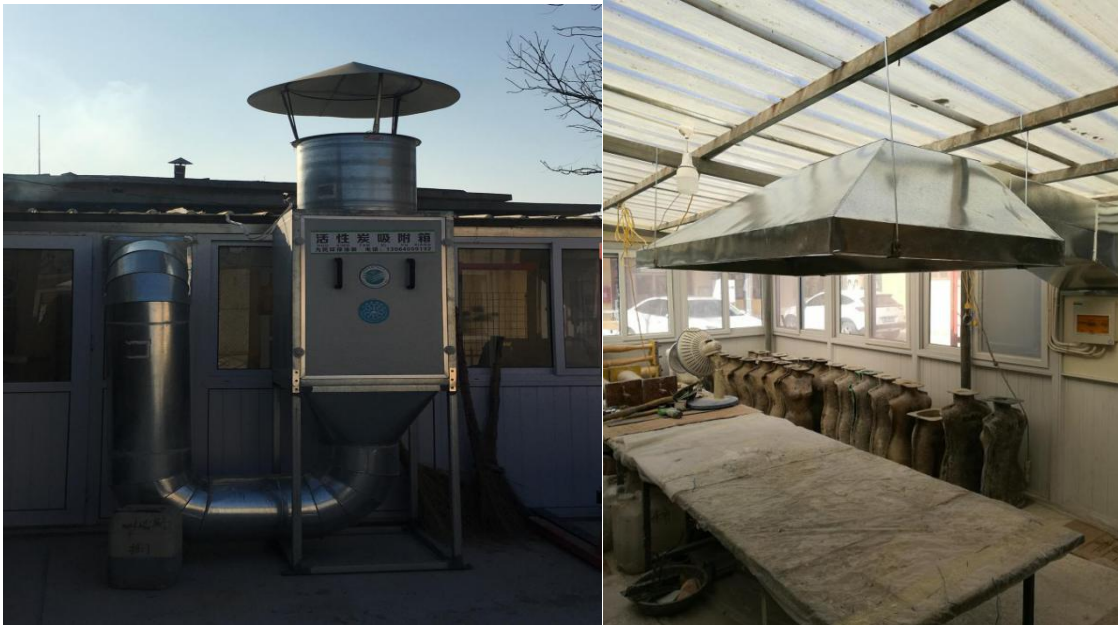
图 2 活性炭吸附装置现场照片
