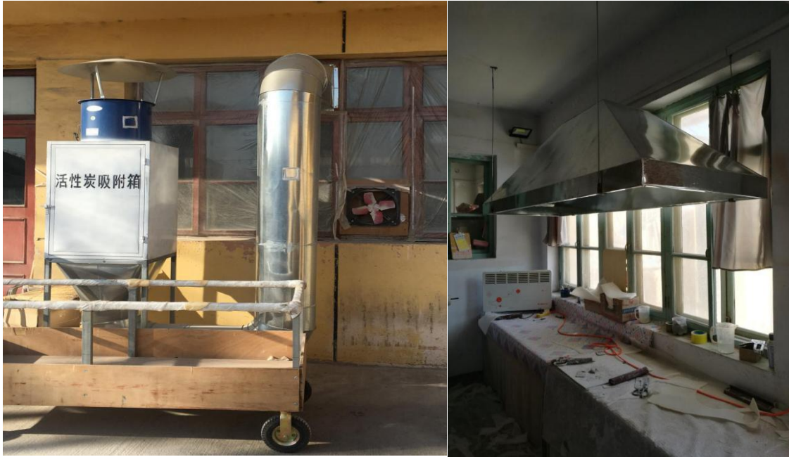
图 3 活性炭吸附装置现场照片
