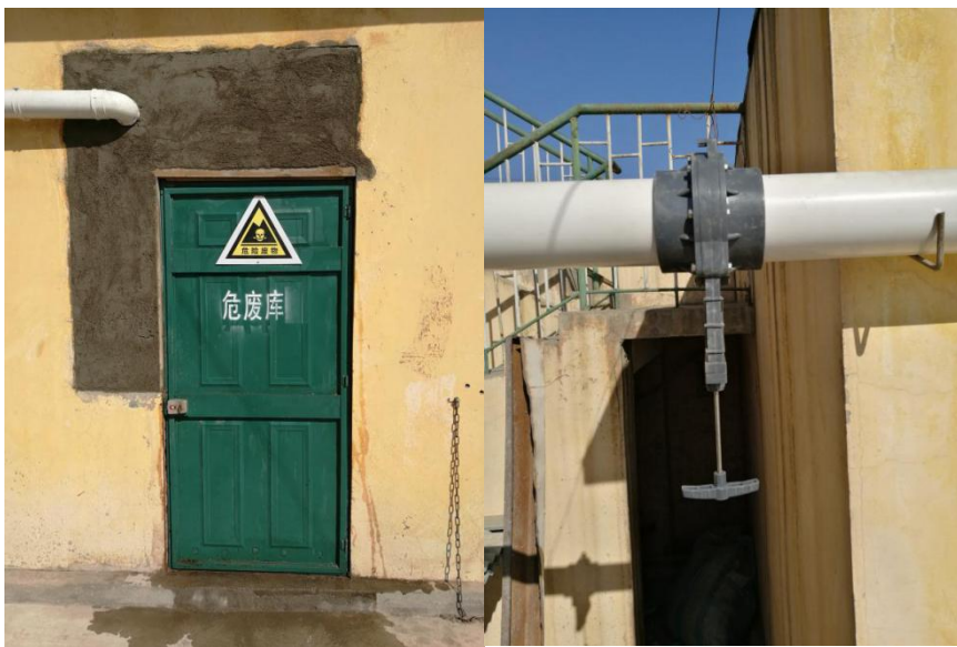
图 6 危险废物暂存库现场照片
