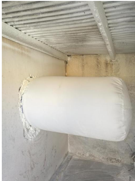
图 4 布袋除尘器现场照片
